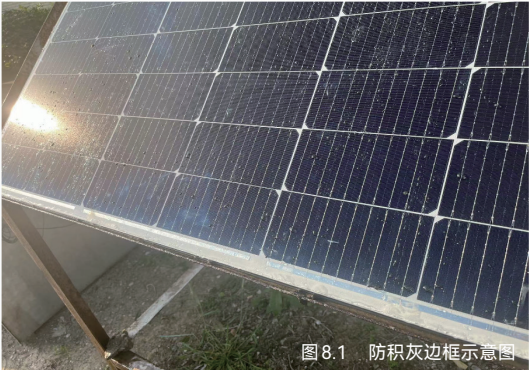
图 8.1 防积灰边框示意图
